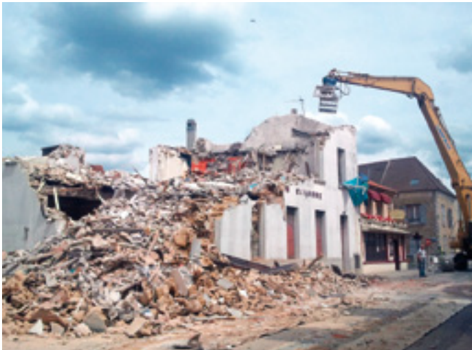
Démolition de la maison commune
